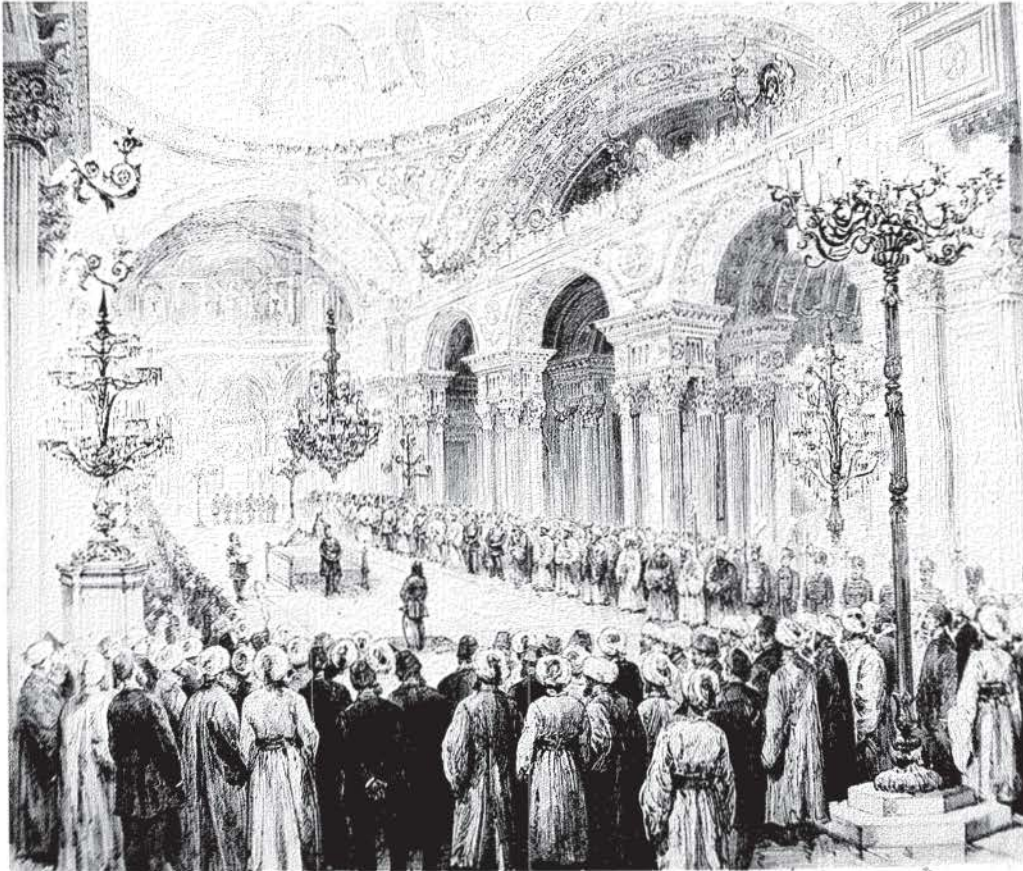
1 Dolmabahçe Sarayı, Muayede Salonu.
