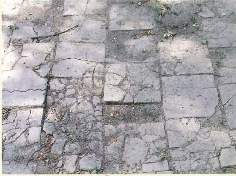
4-5 Kare formlu yassı tuğla dizilerinden ve Malta taşından oluşan döşeme tabanı.
