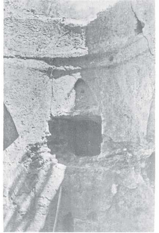
FOTO:13 Duvar nişleri
