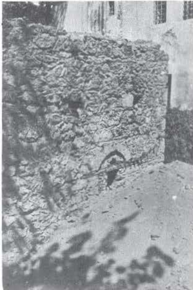
FOTO: 4 Güney cephe
