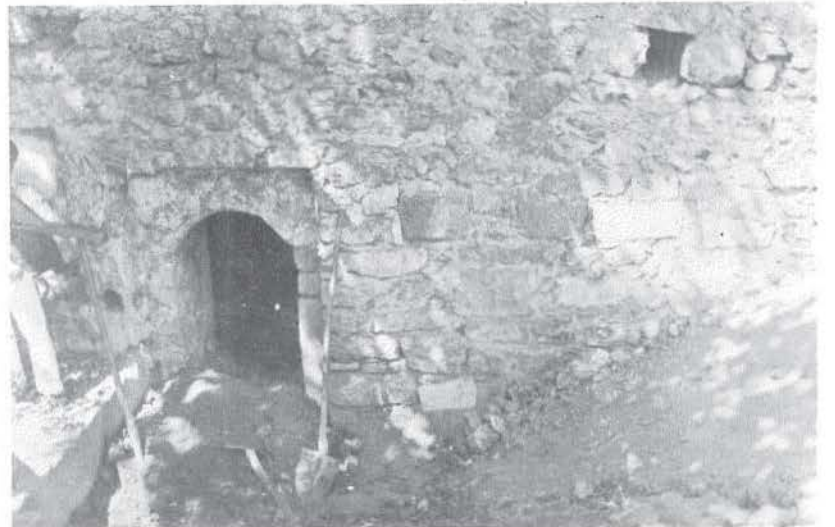
FOTO: 5 Güney cephe
