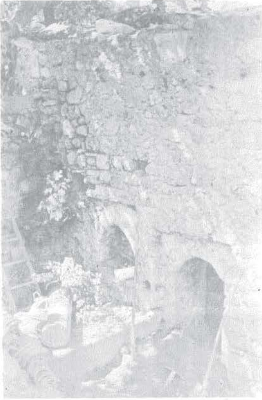
FOTO: 6 Güney cephe
