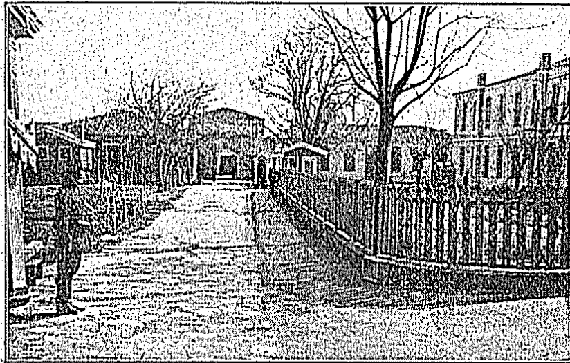
عملیات مکتبی اتخاذ اولنان کلخانہ خستہ خانہ سی Hôpital Gulhané
