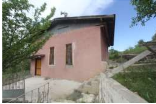
Foto. 20. Karşıbağ Camisi kuzeyden görünüş
