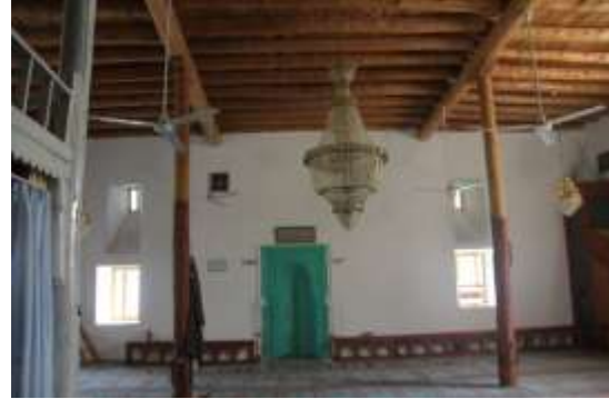
Foto.42. İbrahim Ağa Camisi iç mekandan görünüş
