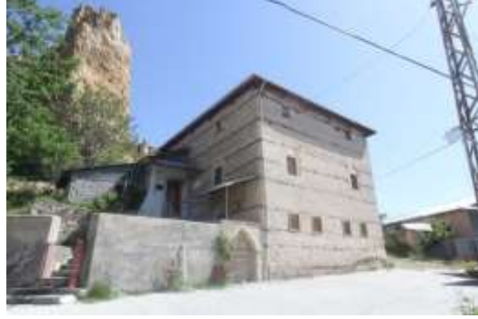
Foto.22. Mektepönü Mahallesi Camisi güneyden görünüş
