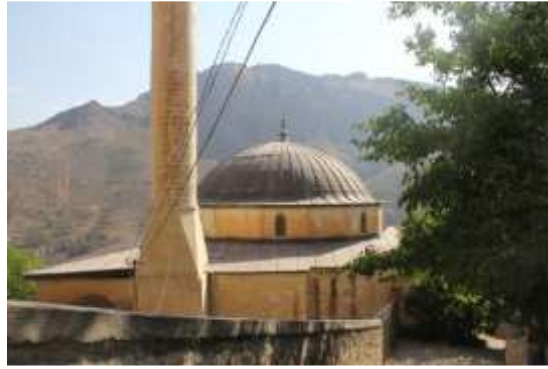
Foto.58. Orta Camisi batıdan görünüş
