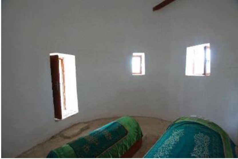
Foto. 13: Aydın Bey Türbesi, İç Mekânda Pencere ve Giriş Kapısı
