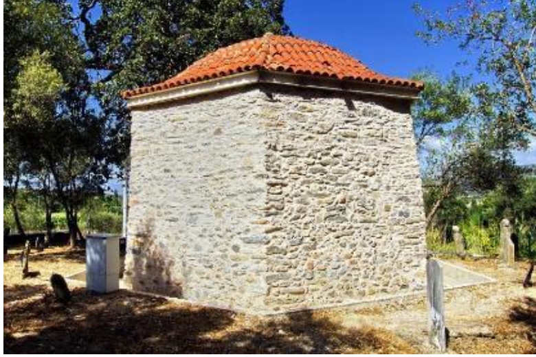
Foto. 6: Aydın Bey Türbesi Güneydoğu Cephe
