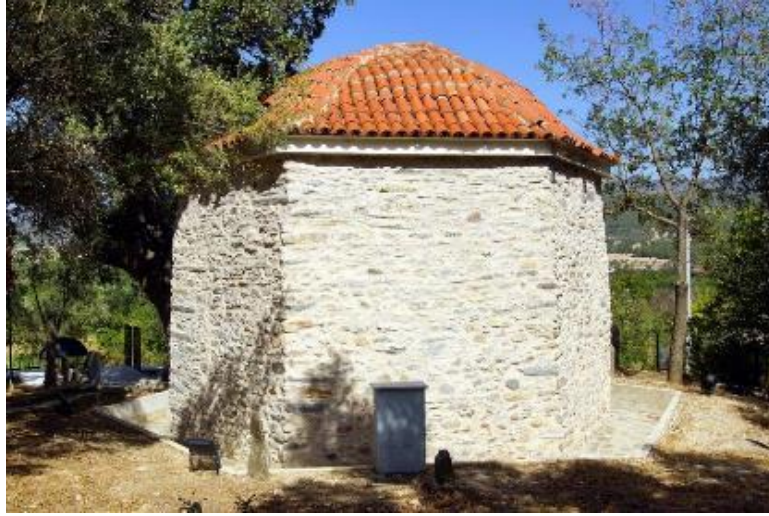
Foto. 5: Aydın Bey Türbesi Batı Cephe
