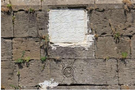
Fotoğraf 24. Seyyid İbrahim Türbesi Giriş Açıklığı Kirişi
