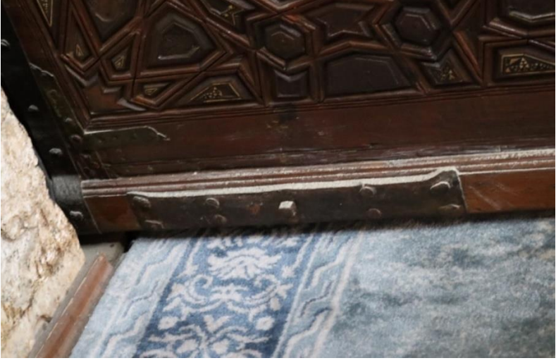
Resim-21: Minber tekerlek kısmına denk gelen düz köşebent
