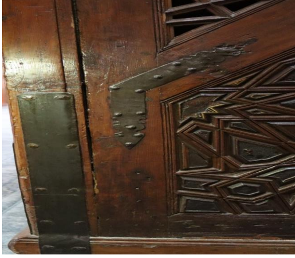
Resim-12: Minber köşebent detayları
