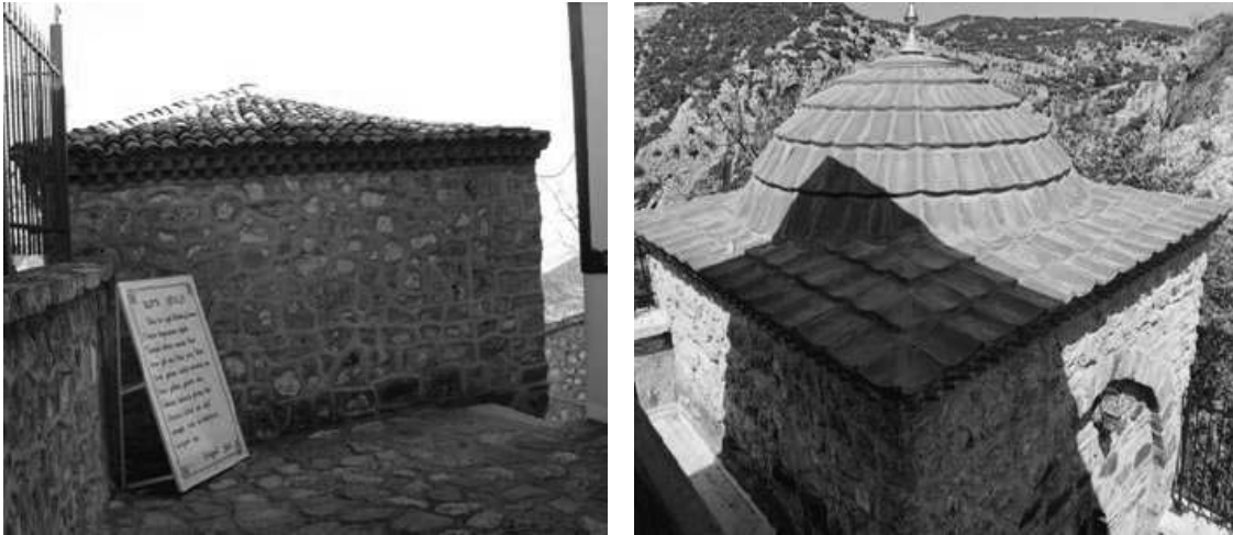
Resim 8: Malhatun Türbesi batı ve güneybatı cepheleri görünümü
