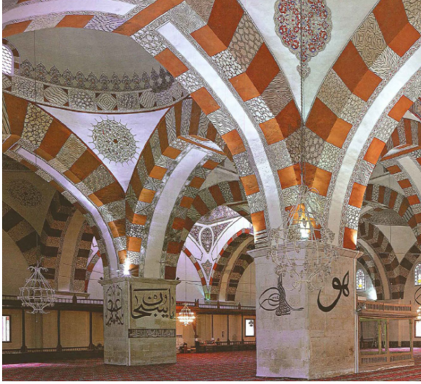
Şekil 6. 1751/52 depremi sonrasında hasarları gidermek için güçlendirildiği belirtilen doğu payandaları (Kuban, 2007)
