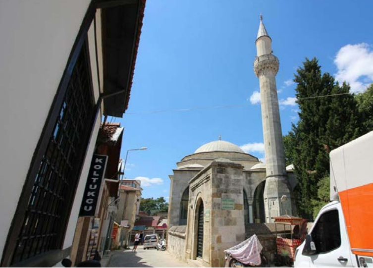
Resim 12: Caminin restorasyon sonrası görünümü. ( http://rstyapi.com.tr/ )
