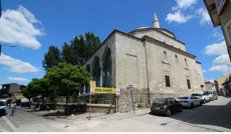
Resim 13: Caminin restorasyon sonrası görünümü. ( http://rstyapi.com.tr/ )
