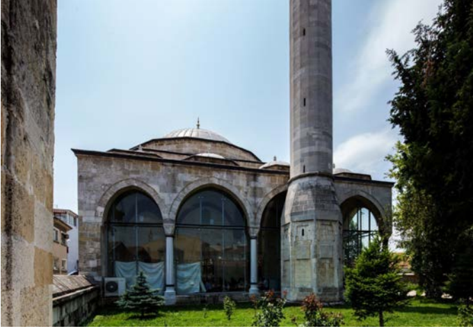
Resim 3: Lâri Camii ana kısımdan ayrı olarak inşa edilmiş minaresi
