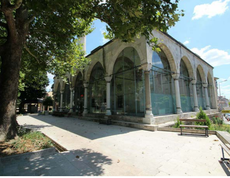
Resim 11: Caminin restorasyon sonrası görünümü. ( http://rstyapi.com.tr/ )
