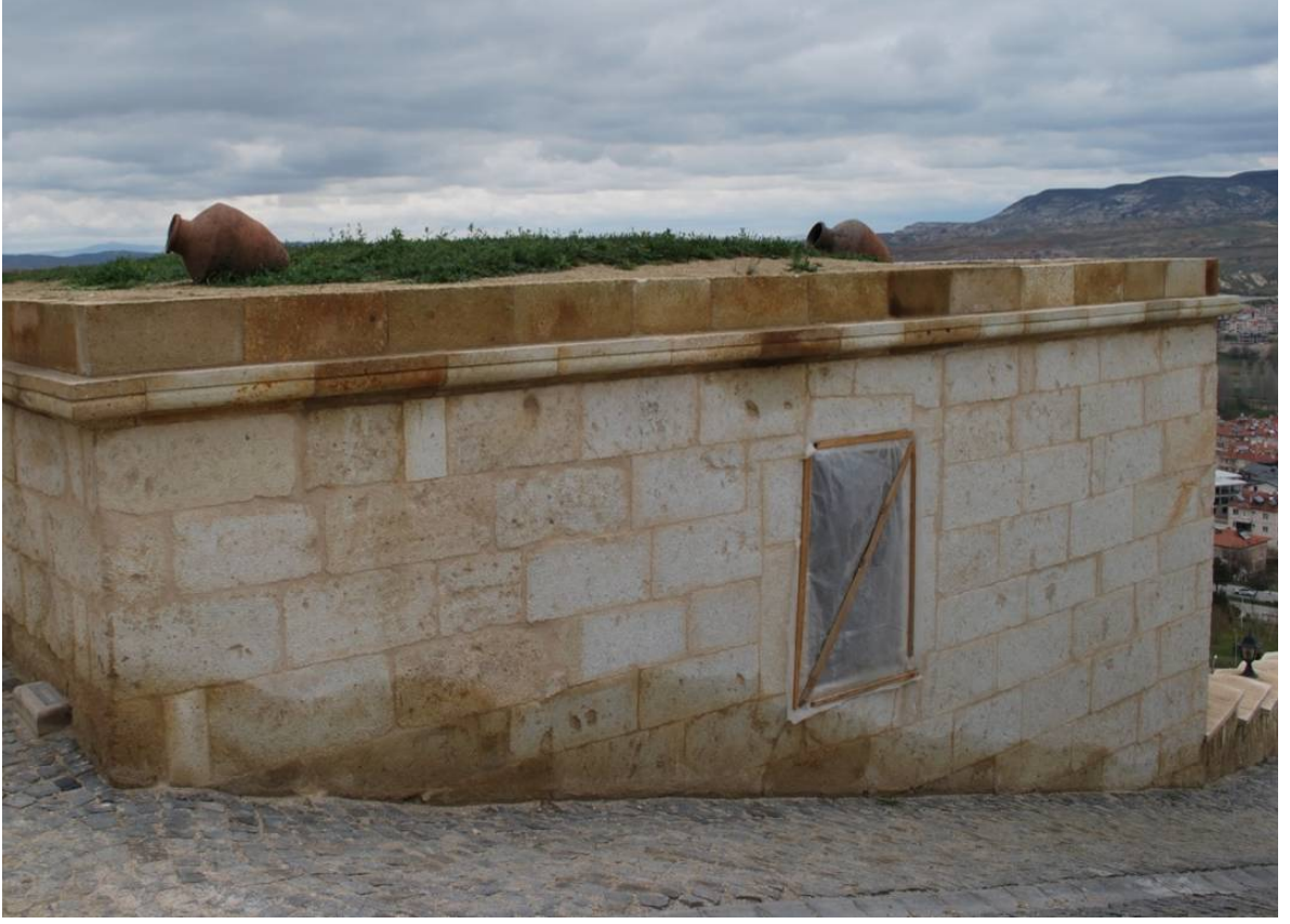
Foto. 13: Güney Cephe Genel Görünüşü.
