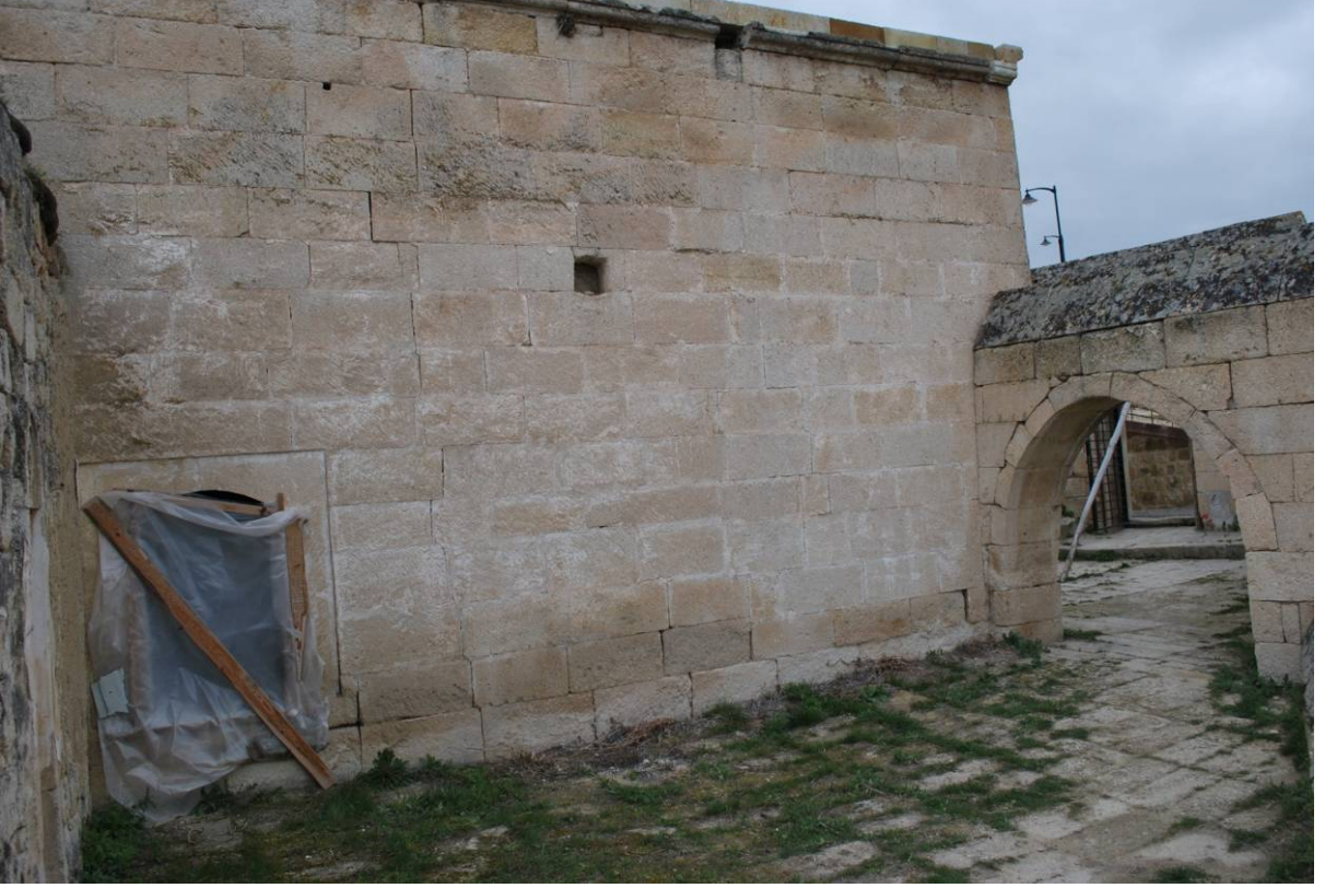
Foto. 30: Yazlık Bölümün Güneyden Görünüşü ve Bu Bölüme Geçit Veren Kapı Açıklığı.
