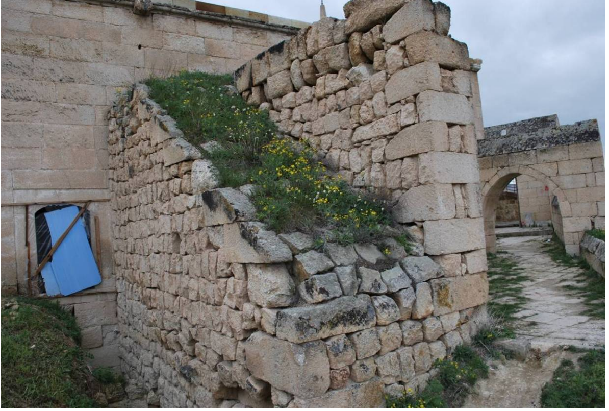
Foto. 15: Dođu Cepheyi Destekleyen Pencereleer Arasındaki Payandanın Görünüđu.
