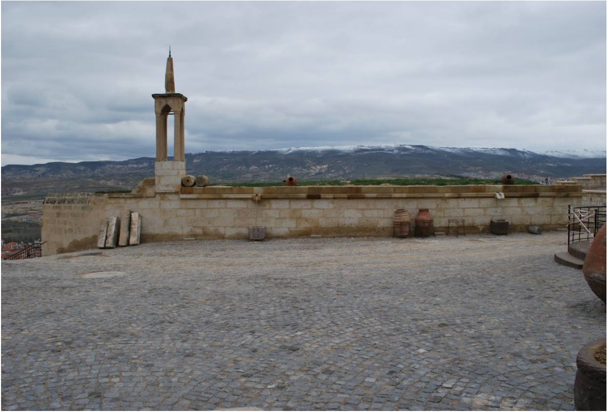
Foto. 12: Batı Cephe Genel Görünüşü.
