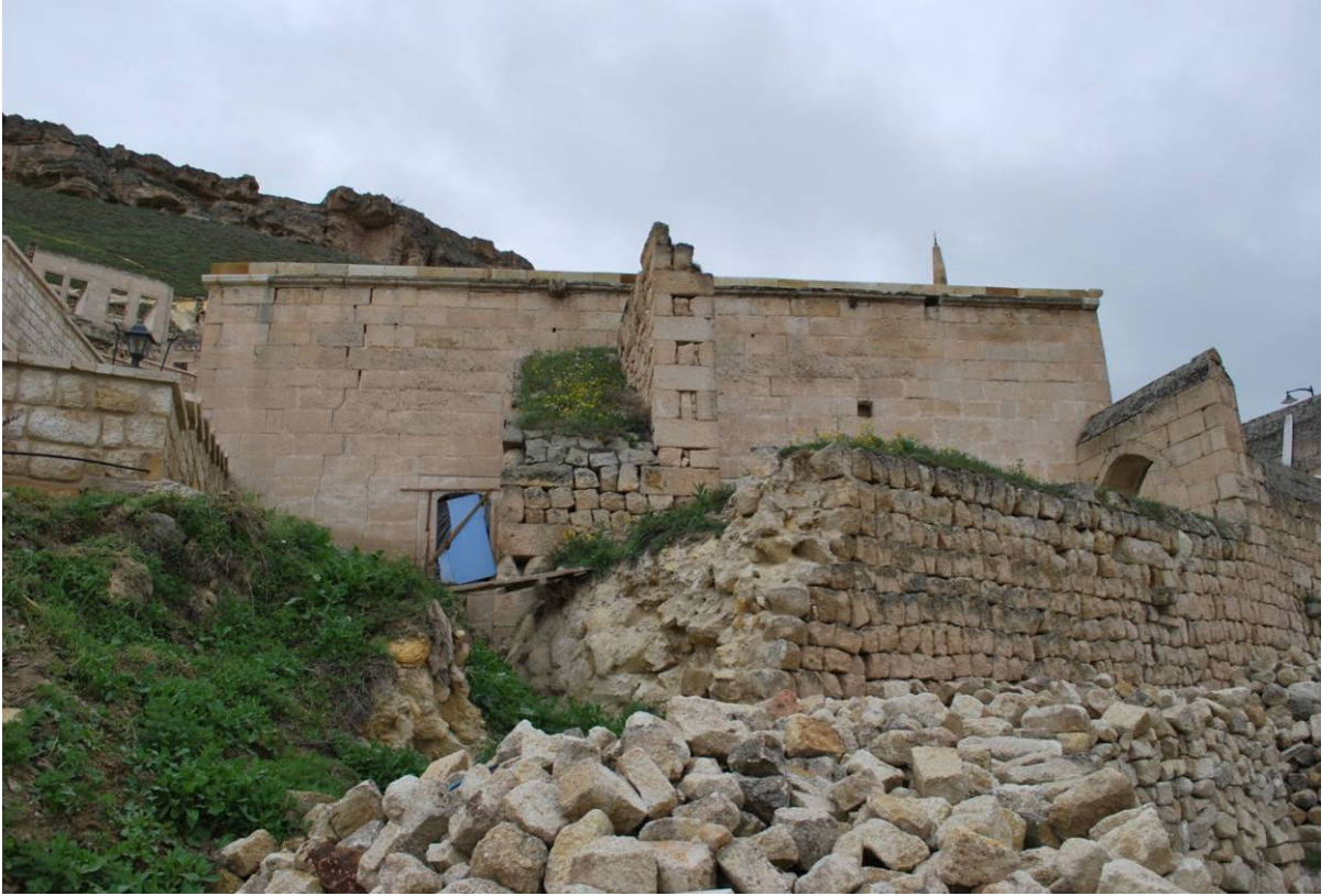
Foto. 14: Doğu Cephe Genel Görünüşü.
