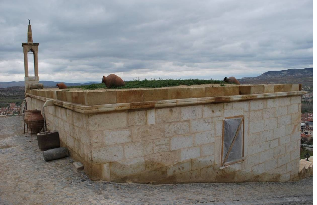
Foto. 4: Davud Ağa Camisi'nin Güneybatıdan Genel Görünüşü.
