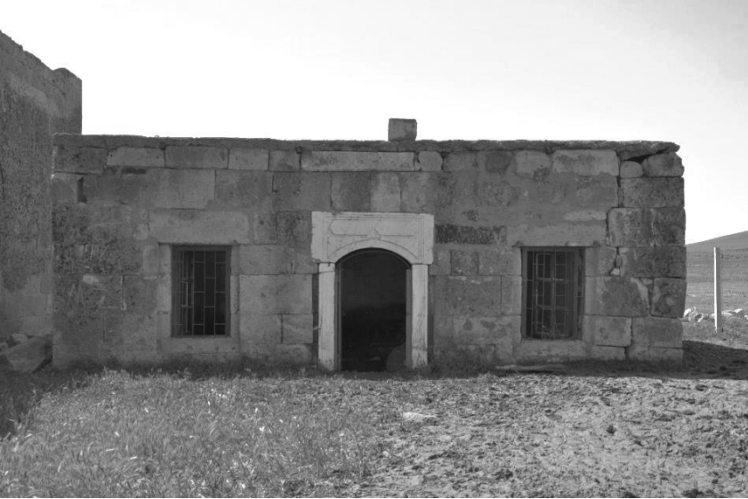
Türbenin giriş cephesi (Haziran 2016)
