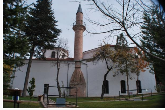
Resim 2: Ak Cami batı cephe
