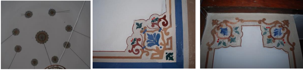
Resim 20-22: Harim kubbesi ile yapının duvarlarında bulunan çeşitli kalem işi süslemeler
