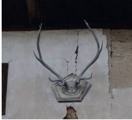
Foto. 45. Gıvrımlar Evi. Bağlarbaşı Mahallesi, Antep Sokak, No: 13. Saçak Altında Geyik Kafatası ve Boynuzu
