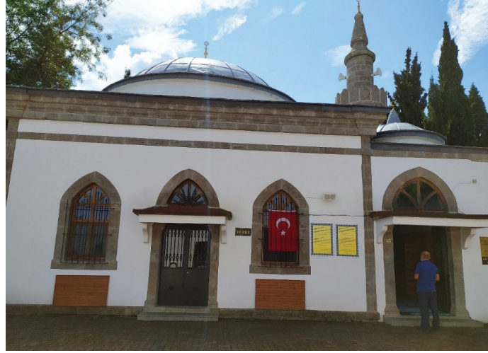
Resim 14: Camiye Bitişik Türbenin Ön Cepheden Görünüşü
