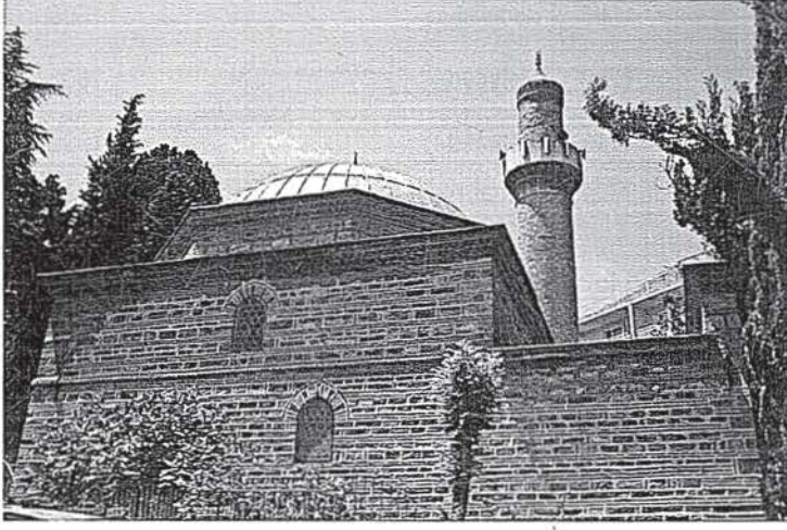
Zeyniler Camii, Foto Aysun Dönmez
