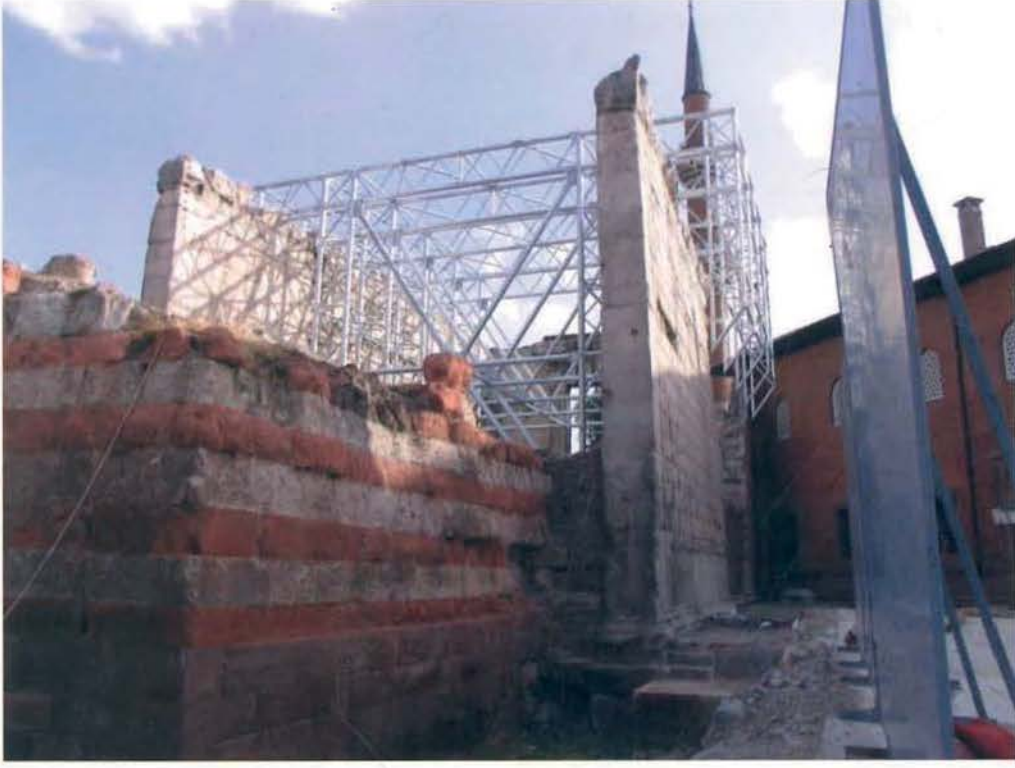
Fotoğraf 3- Augustus Mabedi'ne yapılan payanda ve medresenin derslane eyvanı, kuzeyden
