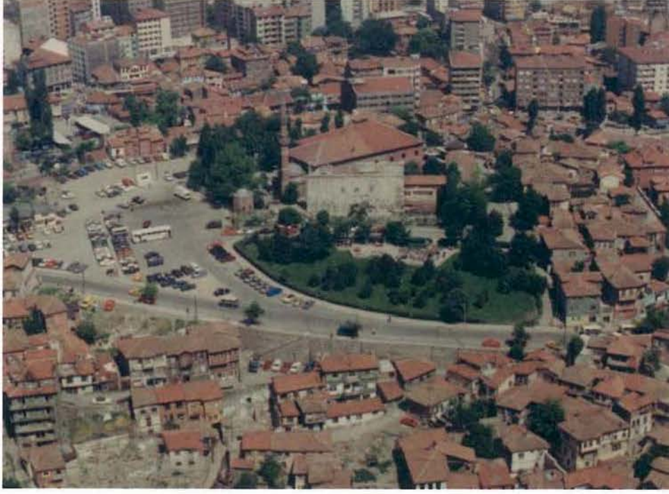
Fotoğraf 1- Hacı Bayram Camii ve Ak Medrese hava fotoğrafı - 1990 (Ankara Büyükşehir Belediyesi Arşivi)
