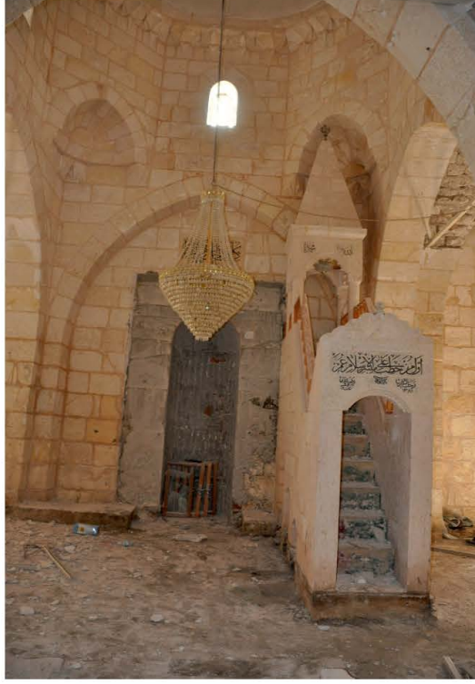
Fot. 31. Son Tamiratta Mihrap Önünde, Mihrap Kaplamaları Söküldükten ve Duvarlar Kumlanarak Temizlendikten Sonra
