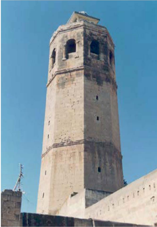
Fot. 24. Ulu Camii Minaresi
