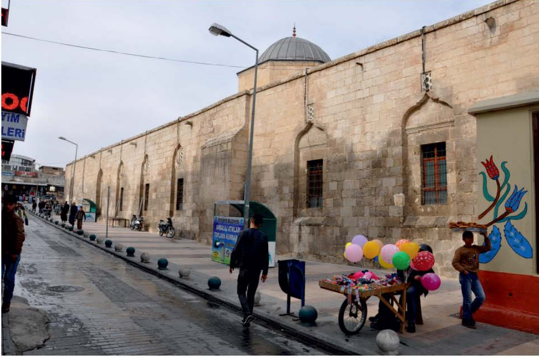
Fot. 15. Urfa Ulu Camii - Güney Cephesi
