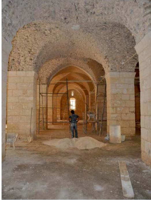
Fot. 32. Son Tamiratta Sahınların Üst Örtülerindeki Sıvalar Raspalandıktan ve Ayaklar Kumlanarak Temizlendikten Sonra
