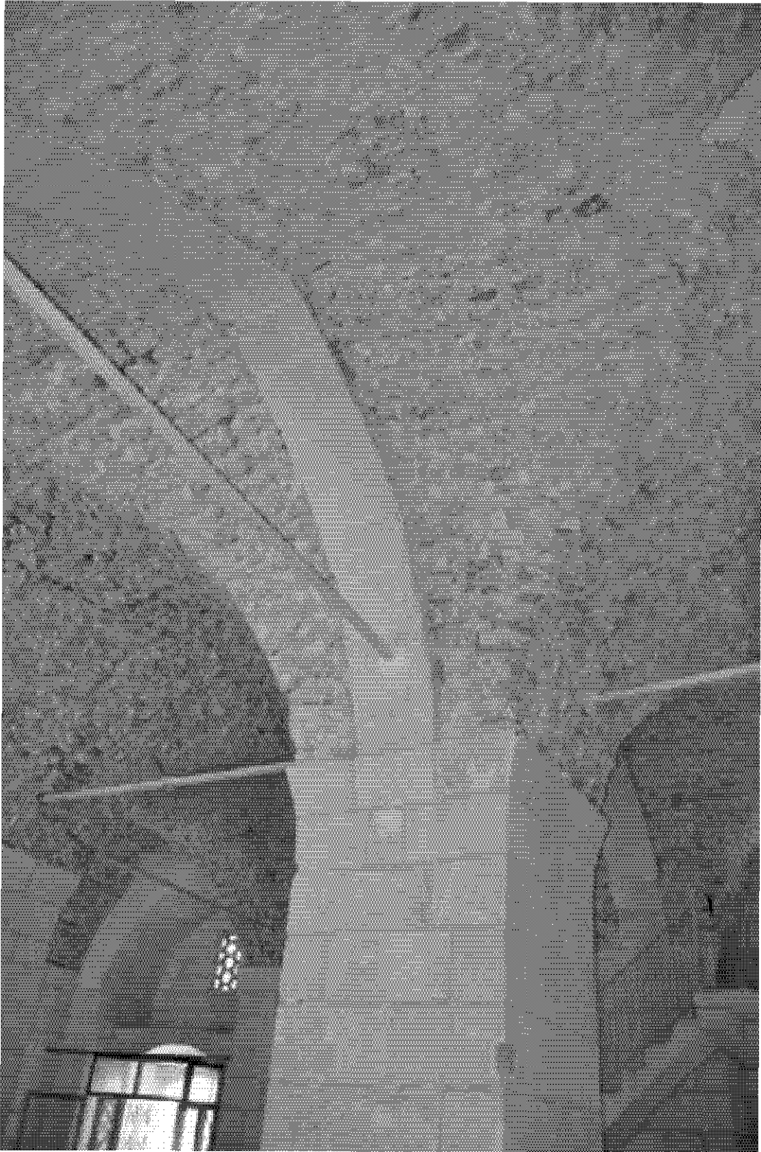
Fot. 33. Son Tamiratta Tonozların Sıvaları Raspalandıktan ve Ayaklar Kumlanarak Temizlendikten Sonra
