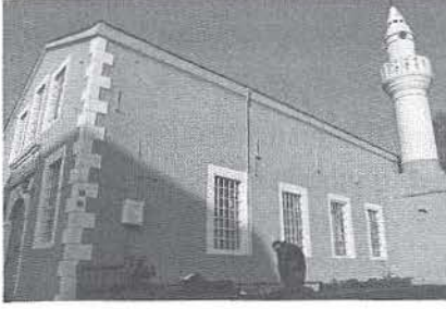
Res. 16: Yapının güneydoğu yan cephesi (N. Özköylü, 2016).
