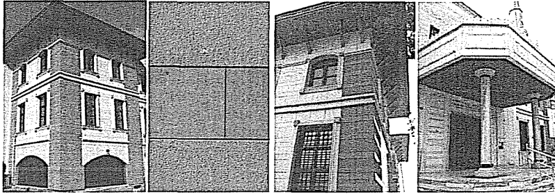
Şekil 6. Dış cephe kaplaması
