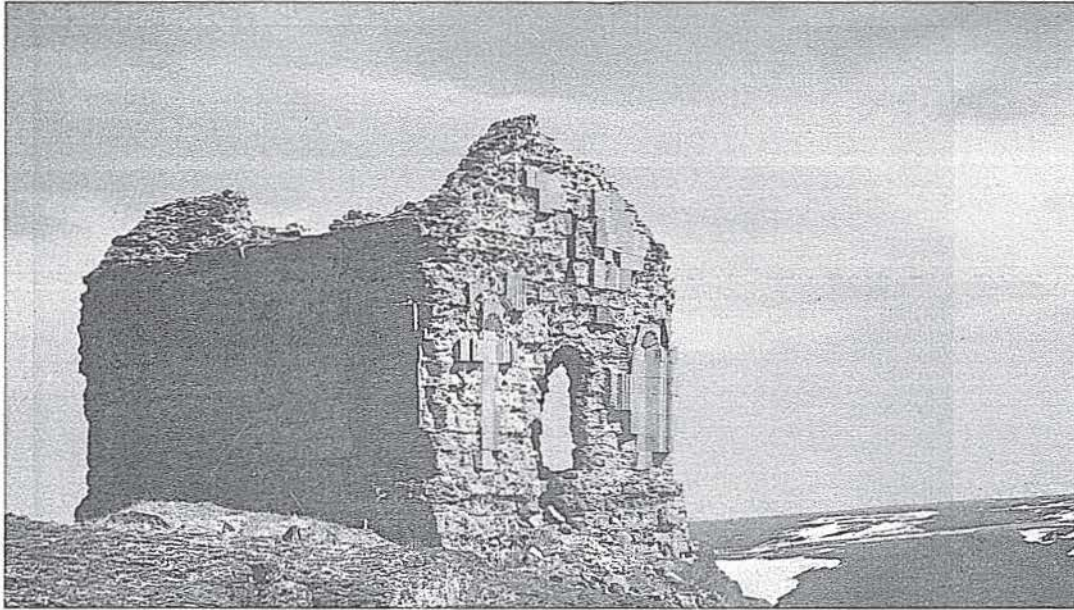
Resim 47: Keçivan Kilisesinden Görüntüm
