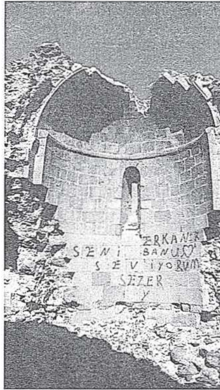
Resim 52: Keçivan Kilisesi Apsisinden Görünüm
