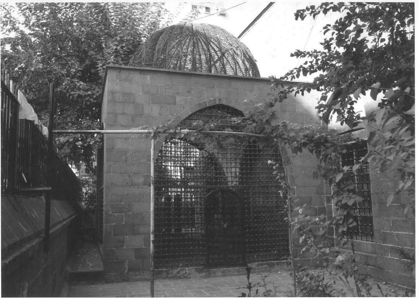
Foto: 41- Zübeyde ve Leyla Hanımlar Türbesi'nin Genel Görünüşü
