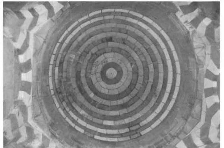
Foto: 12- Sultan Şücaeddin Türbesi Kubbesinin İçten Görünüşü
