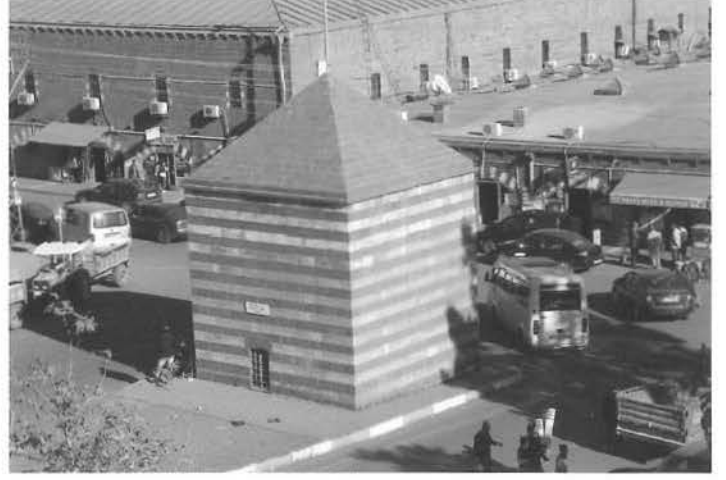
Foto: 10- Sultan Şücaeddin Türbesi'nin Kuzeybatı Cephesi
