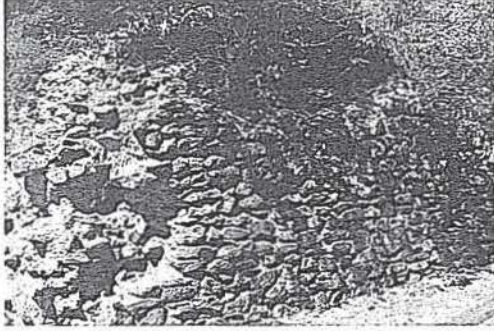
5-Doğan Şah Alp Türbesi doğu cephesi
