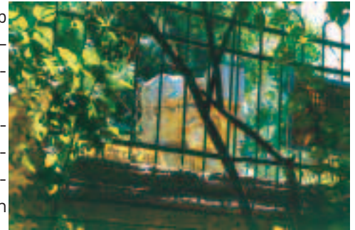
Resim14: Aynı türbe, yıkılmış ve küçülmüş dikmeleriyle
