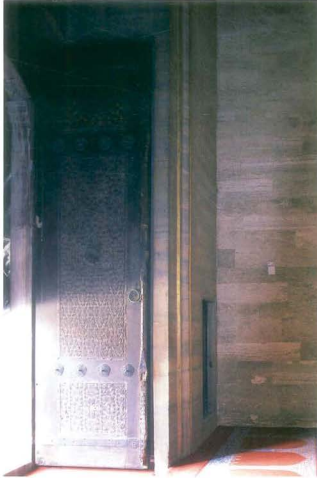
Fot. 1: Kuzey kapı kanadı
