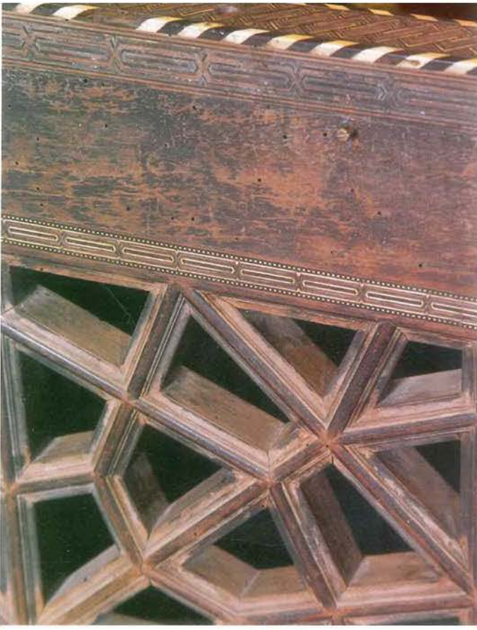
Fot. 22: Hürrem Sultan Türbesi korkuluk
