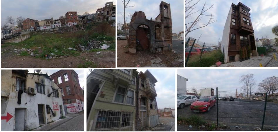
Şekil 15. Mevcut durum analiz lejantındaki kavramlar, sırasıyla; 1)Mevcutta boş parsel, 2)Harabe, 3)Kullanılan yapı, 4)Kullanılan yapı, 5)Kullanılmayan yapı, 6)otopark (Özen, 2021)
