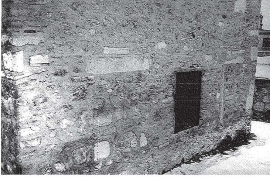
Resim 3. Akşehir Seyyid Mahmud Hayran Türbesi , güney cepheden ayrıntı
