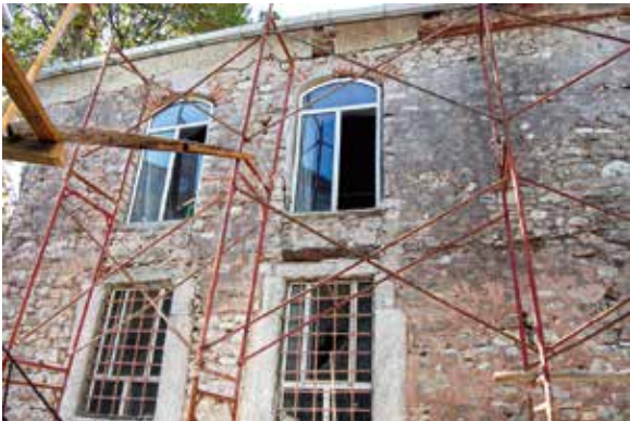
Şekil 14 Caminin doğu cephesindeki raspalardan sonra ortaya çıkarılan ve özgün olan dış cephe duvar sıva örnekleri
