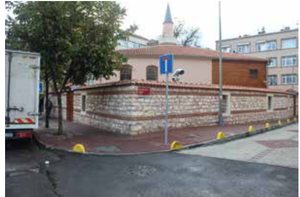
Şekil 36 Bekir Paşa Camii'nin haziresine ait duvarın alt kotlarındaki moloz örgü. Üst kotlar betonarme olarak yapılmıştı
