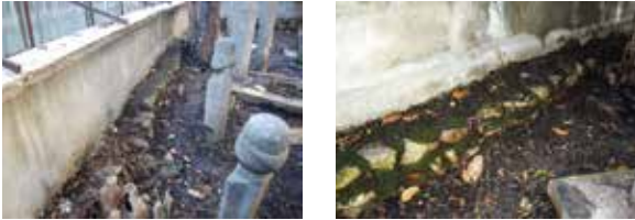
Şekil 36 Bekir Paşa Camii'nin haziresine ait duvarın alt kotlarındaki moloz örgü. Üst kotlar betonarme olarak yapılmıştı
