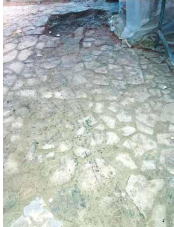
Şekil 15 Harim zemininde parçalanmış şeşhane ve az sayıda taş ile oluşturulmuş döşeme
