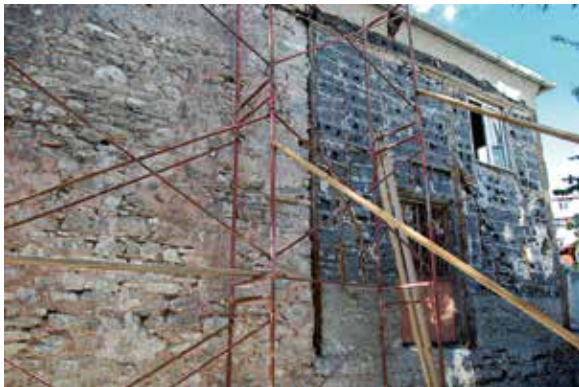
Şekil 16 Caminin 1970'lerde örülen son cemaat yerinin briket malzemesi ve arada kullanılan ahşap hatıllar. Hatılların bazılarının oldukça eski oluşu, bunların eski son cemaat yerine ait olabileceğini düşündürmektedir
