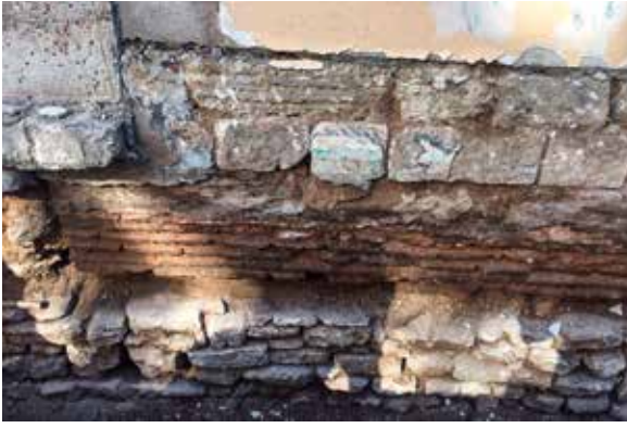
Şekil 22 Son cemaat yerinin subasman kotunun özgün duvar örgüsü. Aslında en alt kısım ampattan gibi düşünülmüşken, üst kotta iki farklı dönem müdahalesi görülmektedir
