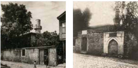
Şekil 37 Kocamustafapaşa'daki Hacı Hamza Camii çevre duvarı moloz taştan olup, avlu kapısı çift kanatlı ve ahşaptandır
