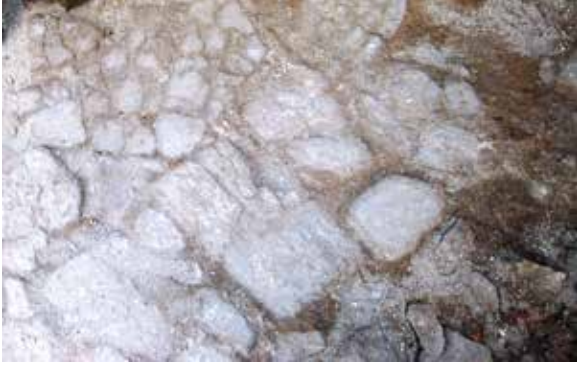
Şekil 31 Son cemaat yerinin devşirme döşemeleri. Bu bölümde Bizans döneminden devşirilmiş çeşitli mermer parçalar olduğu gibi, muhtemelen cami hariminden alınmış altıgen tuğla döşeme de mevcuttur. Ancak bir kısmı tamamen dağılmış vaziyettedir.
