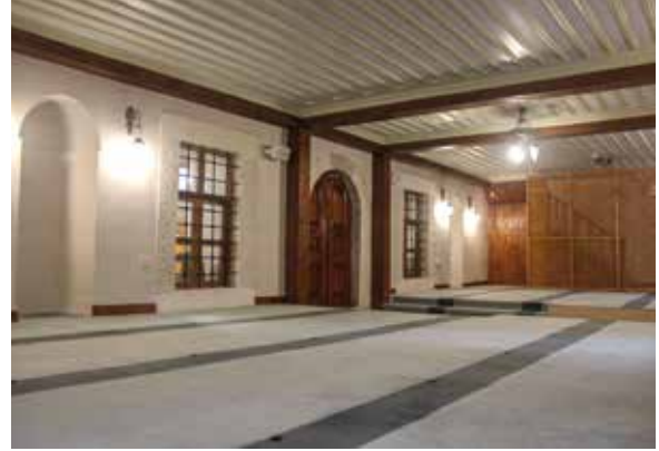
Şekil 31 Son cemaat yerinin devşirme döşemeleri. Bu bölümde Bizans döneminden devşirilmiş çeşitli mermer parçalar olduğu gibi, muhtemelen cami hariminden alınmış altıgen tuğla döşeme de mevcuttur. Ancak bir kısmı tamamen dağılmış vaziyettedir.
