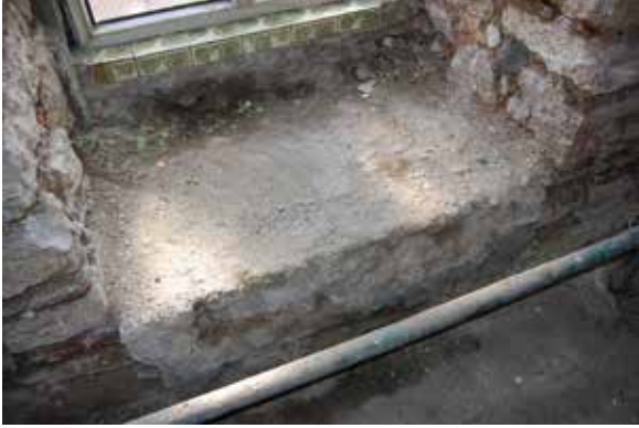
Şekil 13 Alt kat pencerelerinden birine ait denizlik kısmının özgün örgüsü. Zemine oldukça yakın kottadır
