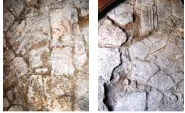
Şekil 30 Son cemaat mahallinin sekisi üzerinde devşirme döşeme malzemeleri ve muhtemelen mescidin içinden alınarak devşirilmiş altıgen döşeme tuğlaları
