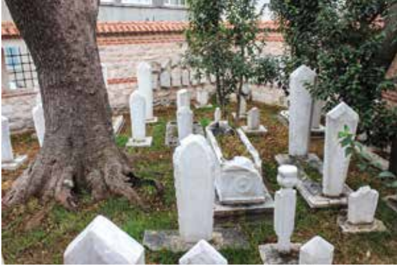
Şekil 41 Restorasyon öncesi Bekir Paşa Camii haziresi
