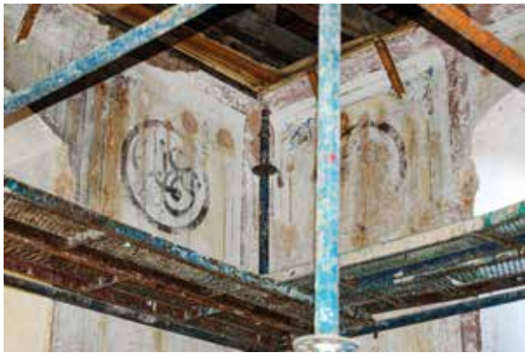
Şekil 24 Raspa sonrasında çıkarılan barok döneme ait kalem işi motifleri ve yine kalem işi olarak duvara uygulanmış cihar-ı yar-ı güzin levhaları
