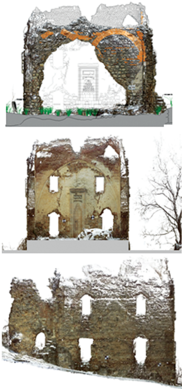
Şekil 2. Optik ve scanner sistem ile yapının ölçümü.
