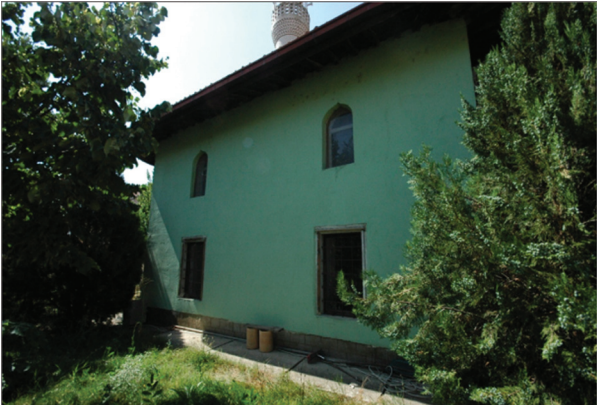
Fotoğraf 23. Gazi Ali Bey Camisi'nin güneydoğu cephesi (AY-MİR Mimarlık Müh. Ltd. 2015).
