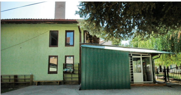
Fotoğraf 24. Gazi Ali Bey Camisi'nin kuzeydoğu cephesi (AY-MİR Mimarlık Müh. Ltd. 2015).
