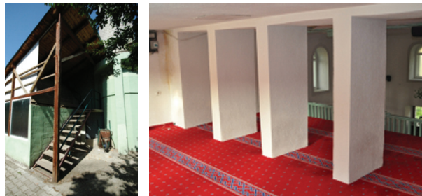
Fotoğraf 17-18. Gazi Ali Bey Camisi'nin kadınlar mahfili girişi ve son cemaat mekânındaki iki katlı betonarme ekin kadınlar mahfilinden görünüşü (AY-MİR Mimarlık Müh. Ltd. 2015).
