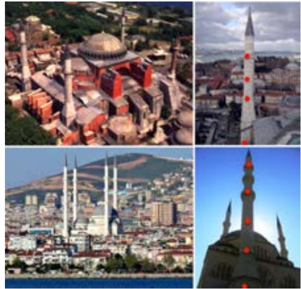
Şekil 11: Aya Sofya Müzesi (üst sıradaki fotoğraflar) ve Maltepe Camii (alt sıradaki fotoğraflar) minarelerine yerleştirilmekte olan deprem izleme ve kayıt sistemlerinin cihaz dağılımı. Maltepe Minaresi'nin fotoğrafları http://wowturkey.com dan alınmıştır
