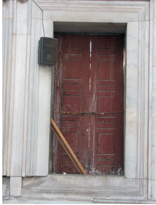
Fotoğraf 5. Avlu pencere kapaklarının genel görünüşleri ve biyolojik bozulmalar.
