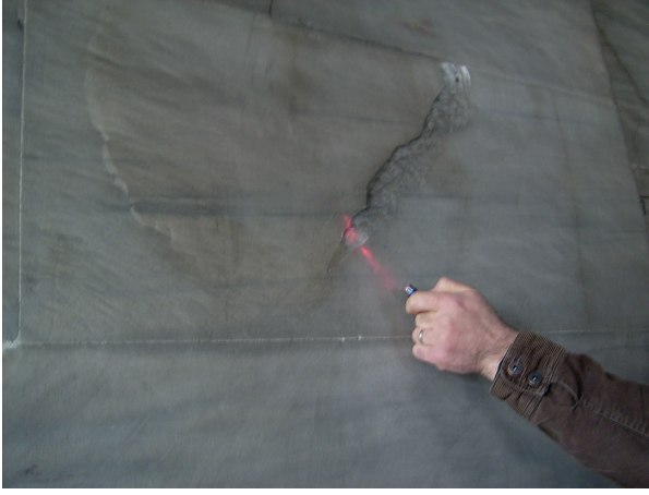
Fotoğraf 6. Harim bölümü mermer kaplamalarda meydana gelen yapraklanmalar biçimindeki problemler.
