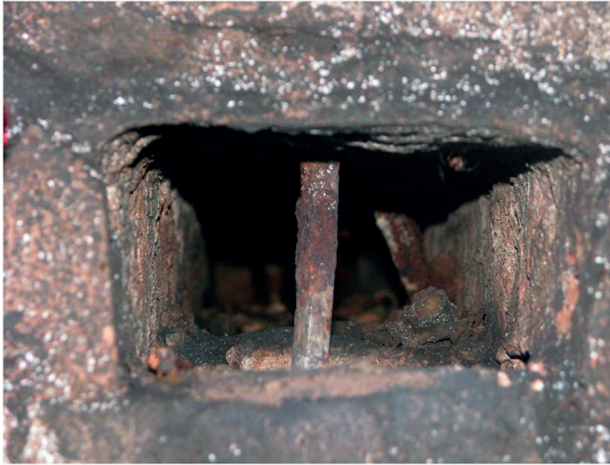
Fotoğraf 14. Cami alt yapısında/bodrum katta, solda temizlenmiş hatıl boşlukları, sağda sağlamaştırma örneği (Durak, 2012)
