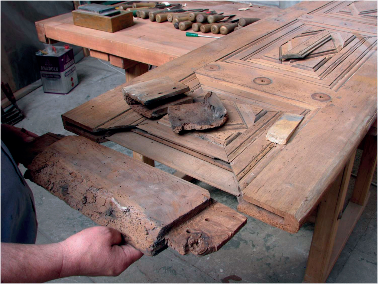
Fotoğraf 12. Ahşap malzemede temizlik-bütünleme-sağlamlaştırma (Durak, 2012)
