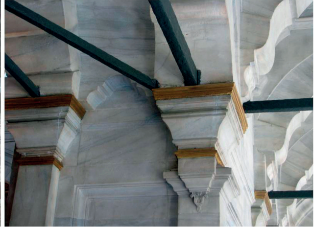
Fotoğraf 10. Kontrollü düşük basınç altında kumla temizlenmiş mermer yüzeyler (Durak 2012)
