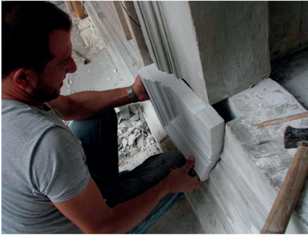
Fotoğraf 13. Mermer yapı elemanı bileşenlerinde temizleme-bütünleme-sağlamaştırma (Durak, 2012)
