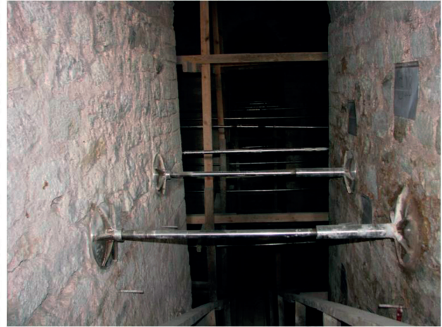
Fotoğraf 14. Cami alt yapısında/bodrum katta, solda temizlenmiş hatıl boşlukları, sağda sağlamaştırma örneği (Durak, 2012)
