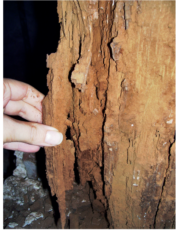
Yeni Cami Hünkâr Kasrı'nda bulunan kullanılamaz durumdaki taşıyıcı meşe dikmeler
