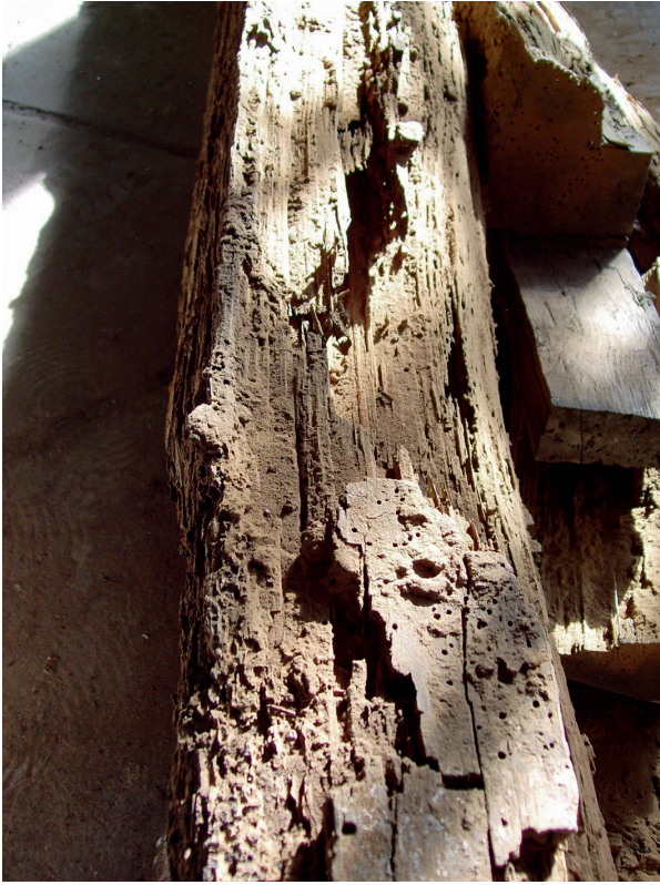
Yeni Cami Hünkâr Kasrı'nda bulunan kullanılamaz durumdaki taşıyıcı meşe dikmeler
