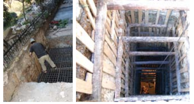
Resim,10- Kuyu çalışmaları sırasında beton demirleri bağlanırken ve kuyu kazılırken
