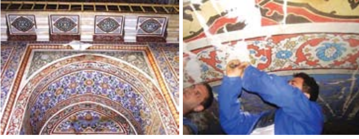
Resim,16- Kalemî yüzeylerde yapılan raspa çalışması
