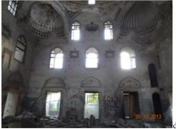
Resim 16. Yapının iç beden duvarlarından görünüm: kuzey cephe (a), güney cephe (b), doğu cephe (c) ve batı cephe (d). (Kaynak: Yazarlara ait fotoğraf arşivi, 2013).
