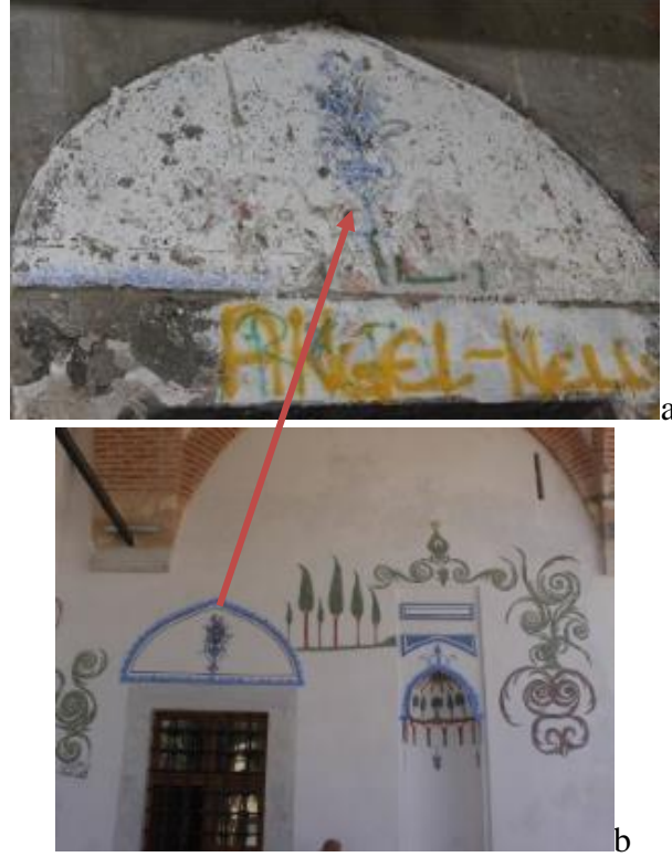
Resim 20. Son cemaat batı tarafında pencere aynasında vazolu çiçek buketinin raspa sonrası görünümü (a) ve pencere aynasının konservasyon ve restorasyon sonrası görünümü (b). (Kaynak: Yazarlara ait fotoğraf arşivi, 2015, 2016).
