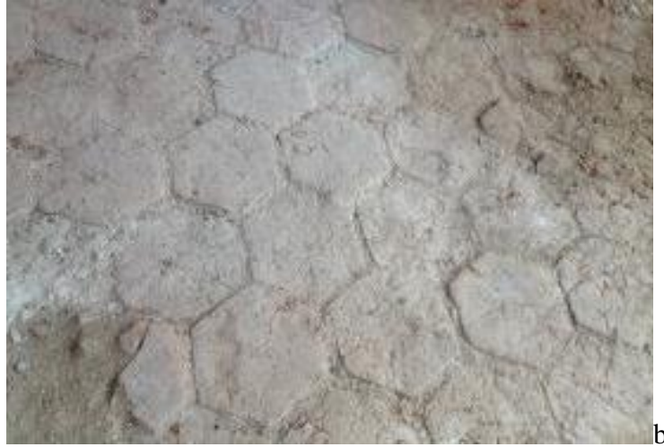
Resim 13. Beton katmanın sökülmesi ile ulaşılan harim (a) ve son cemaatte seki üstü zemininin (b) özgün tuğla döşemesi. (Kaynak: Yazarlara ait fotoğraf arşivi, 2015).
