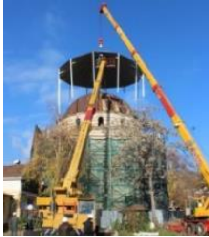
Resim 8. Ana kubbe üstü çelik konstrüksiyon geçici çatı imalatından görünüm. (Kaynak: Vakıflar Genel Müdürlüğü Arşivi, 2014).
