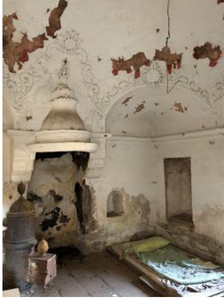
Şekil 17: Fatma Evi Zemin Kat Mekânında Bulunan Ocak ve Metal Profilli Alçı Süslemeli Kubbe. (Fotoğraf: Ekol Mimarlık Arşivi)
