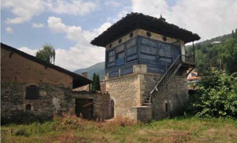
Şekil 15: Kargir Zemin Katı ve Ahşap Panolarla Kapatılan 1. Katı ile Fatma Evi, Hemen İbadethanenin Karşında Yer almaktadır. (Fotoğraf: Ekol Mimarlık Arşivi)
