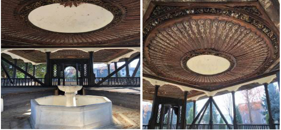
Şekil 7: Şadırvanın Yedigen Mermer Havuzu ve Ahşap Tavanı. (Fotoğraflar: Ekol Mimarlık ve Deniz Özkut Arşivi)
