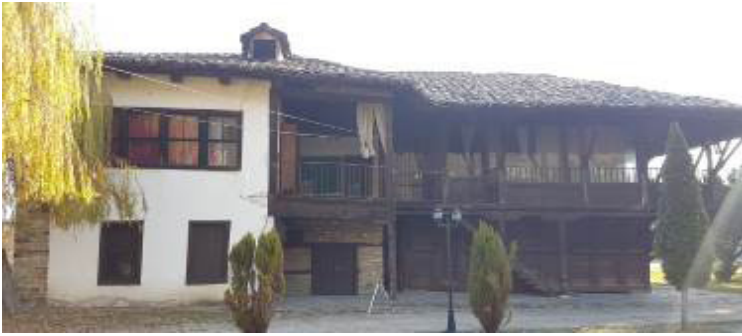
Şekil 28: Yığma Taş ve Ahşap Karkas Yapım Sistemlerinin Birlikte Kullanıldığı Misafirhane Giriş Cephesi. (Fotoğraf: Ekol Mimarlık Arşivi)
