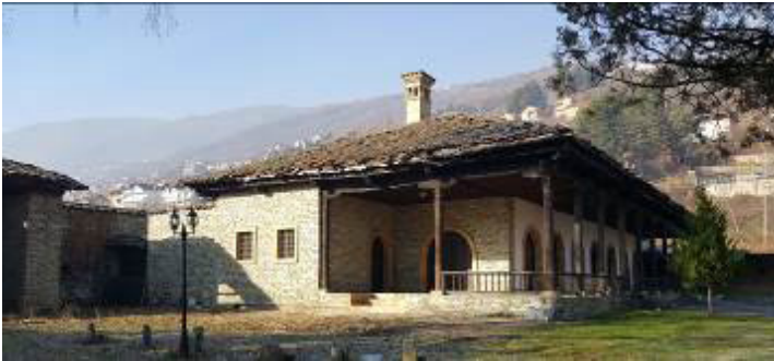
Şekil 38: Bahçe Kapısı Yanında Yer Alan Restoran Yapısı. (Fotoğraf: Ekol Mimarlık Arşivi)
