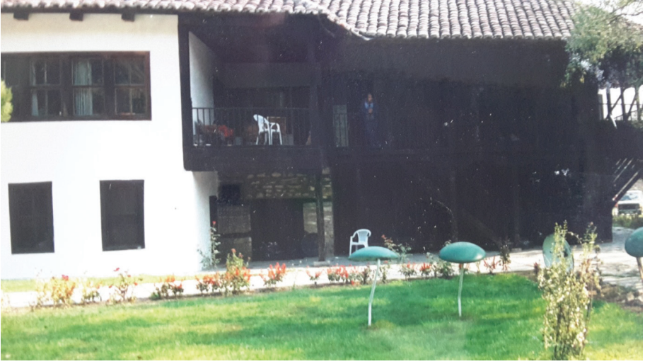
Resim 15: Misafirhane yapısının batı cephesi (Yazarın çektiği fotoğraf)
