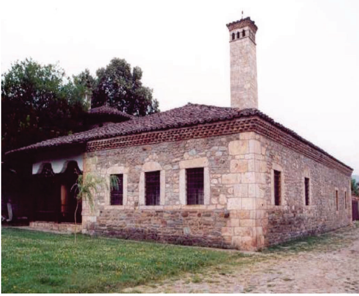
Resim 2: Mescit binasının güneydoğu cephesi (Mediu-Dushi, 2010: 43)
