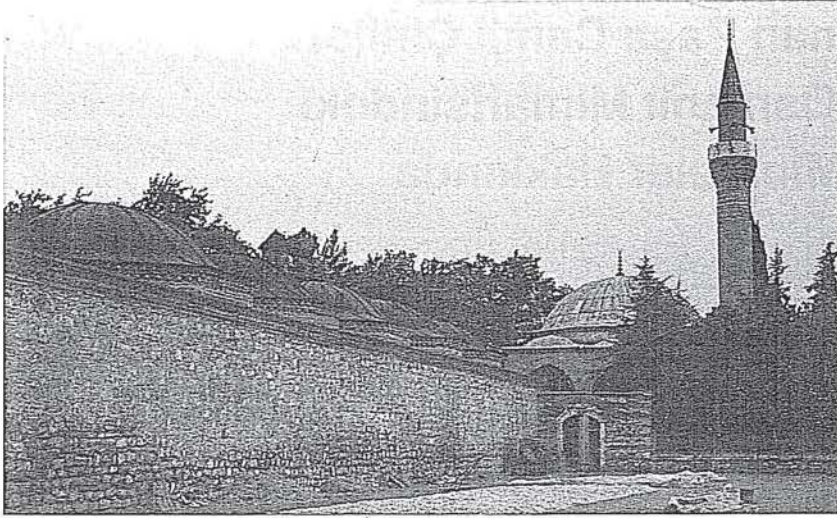
Resim 1: Yenisehir Sinan Paşa Camii'nin medrese yönünden görünümü (2003)
