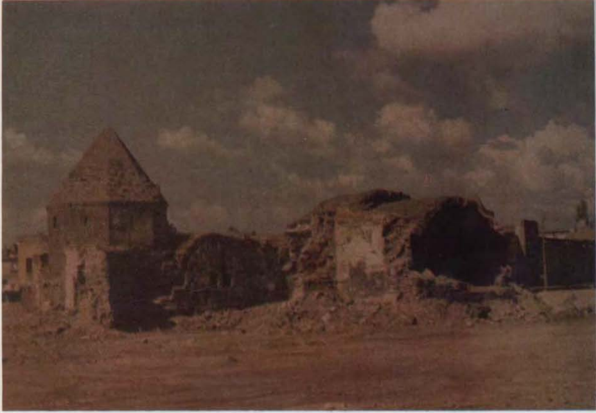
Resim 3: Medrese kalıntılarının güneyden görünüşü (istimlak sonrası).
