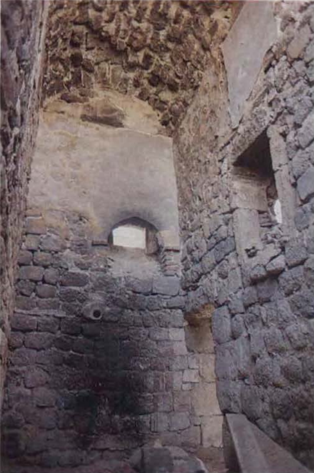
Resim 8: Giriş eyvanının doğrundsaki dar (1 nolu) odanın içinden görünüş.
