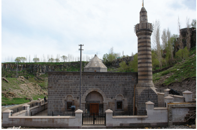
Fot. 2: Hınıs Ulu Camii'nin kuzeyden görünüşü.
