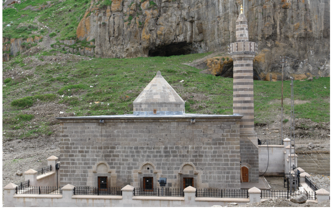
Fot. 3: Hınıs Ulu Camii doğu cephesi görünüşü.
