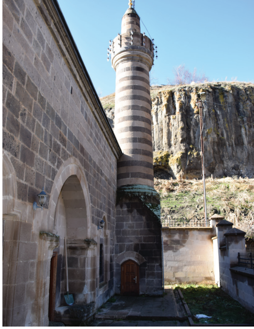
Fot. 5: Hınıs Ulu Camii; minare genel görünüşü.
