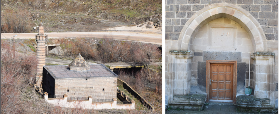
Fot. 1: Hınıs Ulu Camii, güney cephesi ve taçkapısı.
