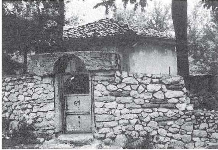
Foto.:1- Şeyh Eylük Türbesi Genel Görünüm.
