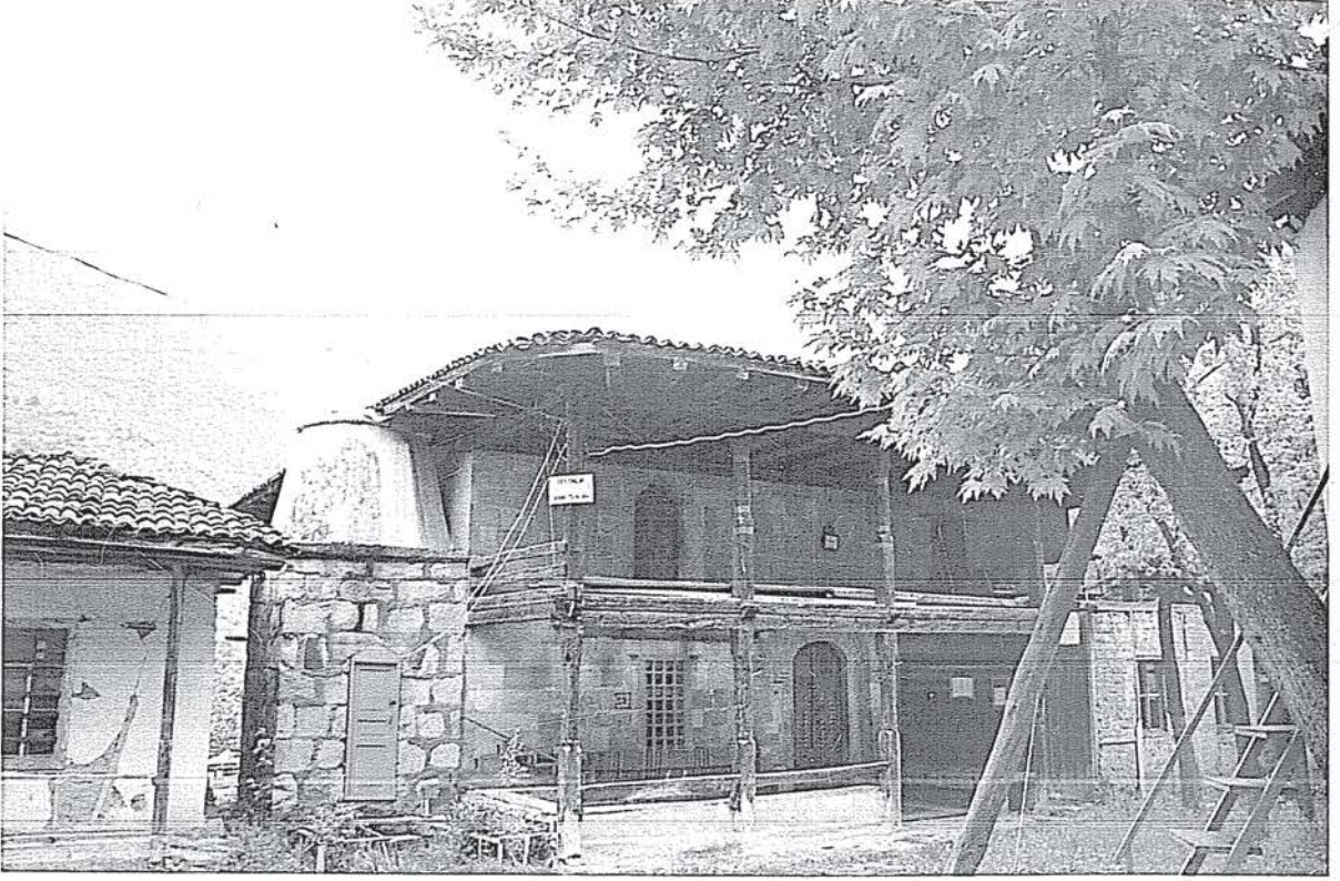
Resim 4. Zeytinlik Köyü Camii [10]
