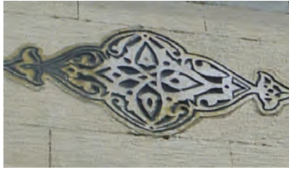
e- Güneybatı cephesi
