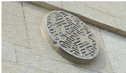
i- Doğu cephesi
