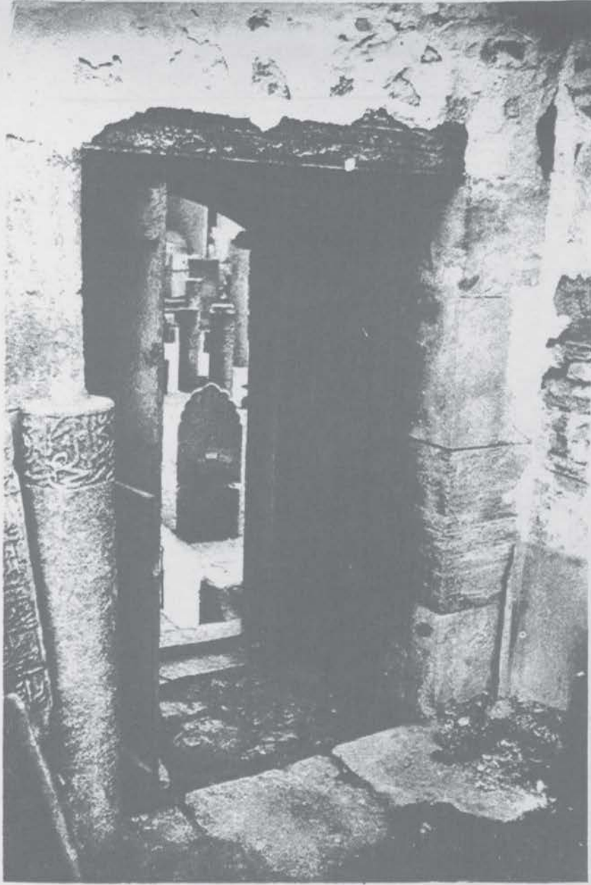
Resim : 13 — Sinop, Alâiye Medresesi, «Türbe» kapısı (içten görünüş)
