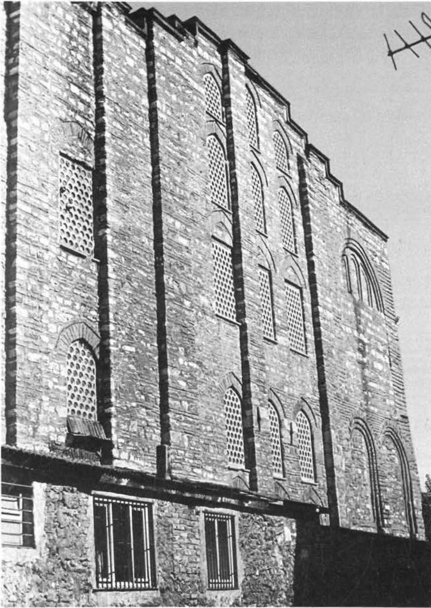
Gül Camii, Güney Dış Cephesi
