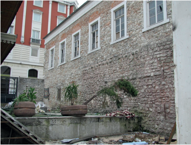
F.10- Safvetî Tekkesi'nin avluya bakan kuzeydoğu cephesi
