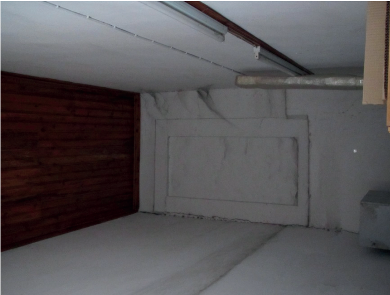
F.4- Safvetî Tekkesi'nde sonradan kapatılan açıklık
