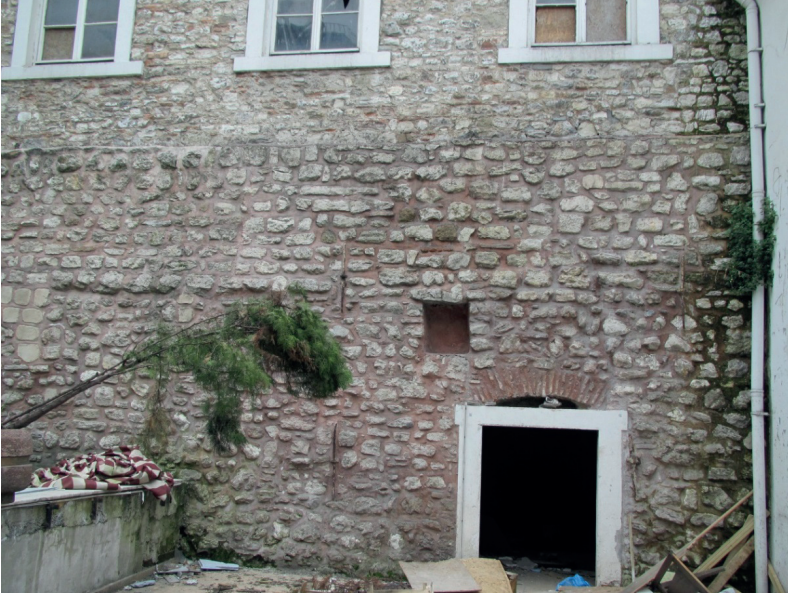
F.3- Bodrum kattaki tonozlu mekânın girişı
