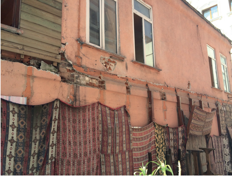
F.17- Meşruta yapısına bitişik kârgir eklenti
