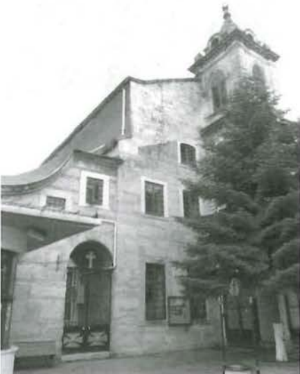
Res. 19: Surp Haç Kilisesi, cephe ve çan kulesi (S. Patacı, 2016).
