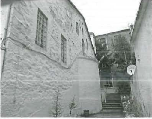
Res. 24: Hagios Georgios Kilisesi, doğu cephesi ve apsis (S. Patacı, 2016).
