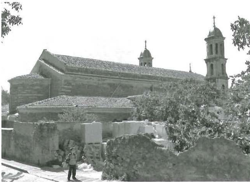
Res. 12: Surp Garabed Kilisesi, apsis ve çan kulesi (S. Patacı, 2016).
