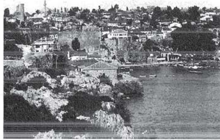
Kaleiçi'nin karakteristik yerleşim dokusu. Falezlerden eski limana ve Kaleiçi'ne bakış
